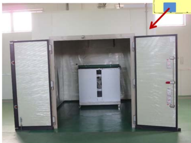
差圧式予冷库区域
